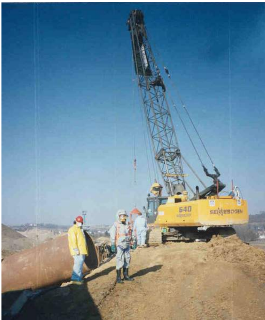
Abbildung 5 Herstellen von Schächten im Sondermüllbereich
