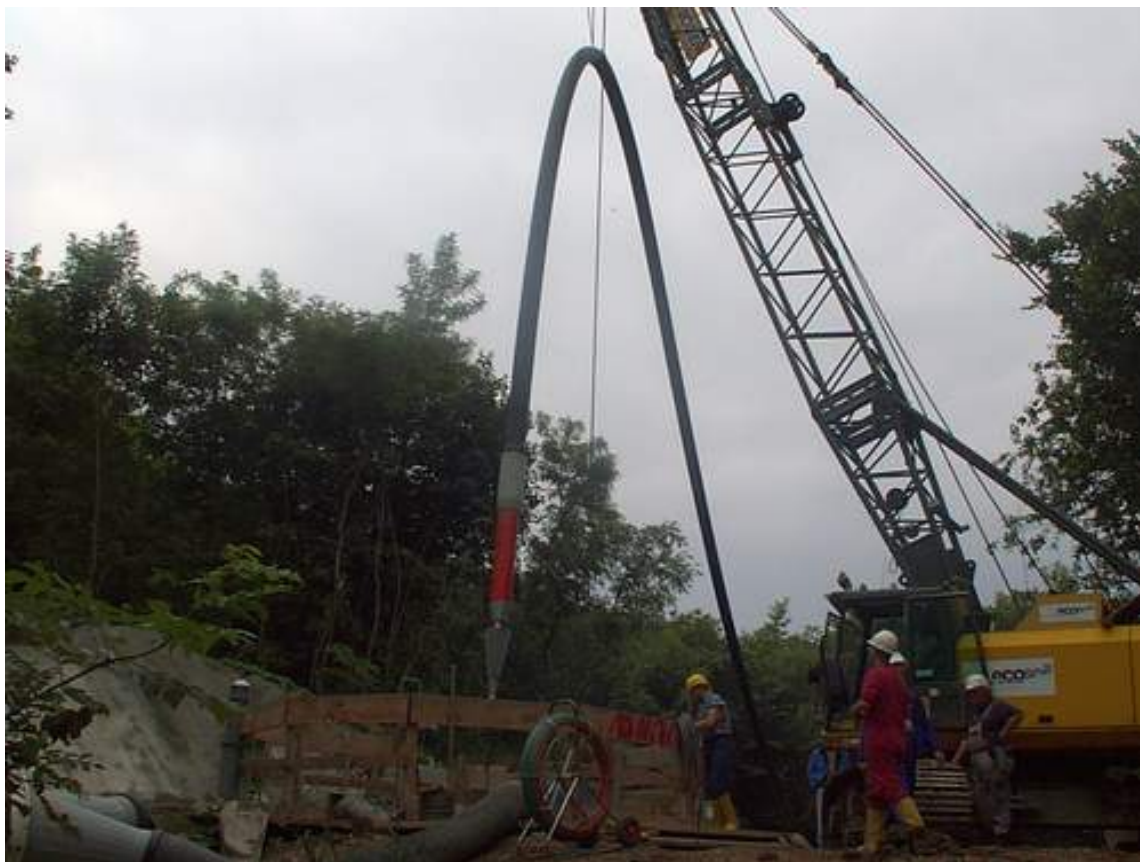
Abbildung 4 Einbringen einer Berstlining-Rakete in den Startschacht
