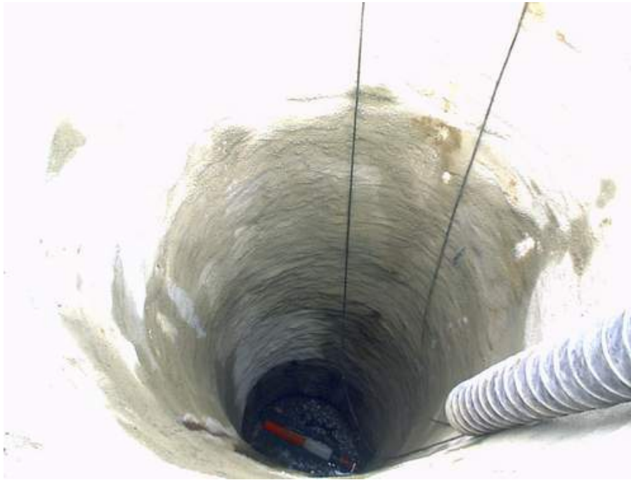
Abbildung 10 Blick in einen Spritzbetonschacht
