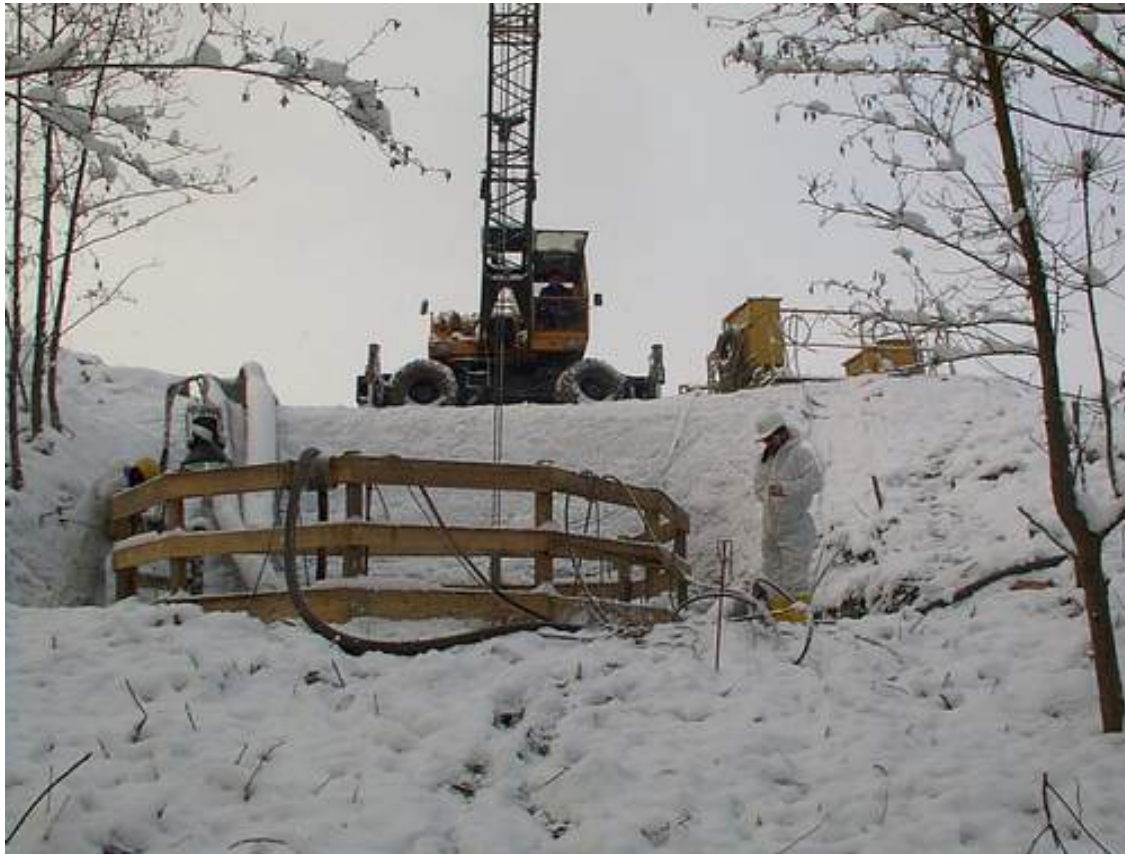
Abbildung 1 Arbeiten am Zugangsschacht auf der Deponie „Am Lemberg“
