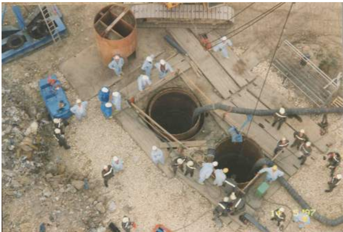
Abbildung 6 Tandemschacht mit Stahlrohrverbau von oben
