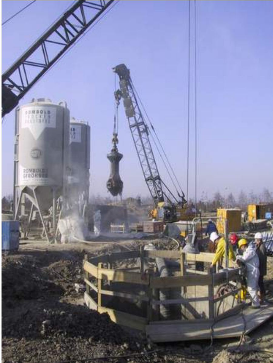
Abbildung 9 Abteufen von Spritzbetonschächten auf der Deponie Am Lemberg
